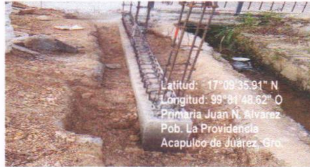
ACERO No. 2, Fy= 2,320 KG/ CM2 EN CIMENTACION, INCLUYE: HABILITADO, ARMADO, DESPERDICIOS, GANCHOS, ALAMBRE RECOCIDO N° 18, FLETES, ACARREOS, HERRAMIENTA, MANO DE OBRA.
