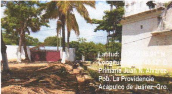
DEMOLICIÓN DE PIEDRA EN CIMENTACIÓN, A MANO CON MARRO Y CUÑA, INCLUYE: MANO DE OBRA, EQUIPO Y HERRAMIENTA.
