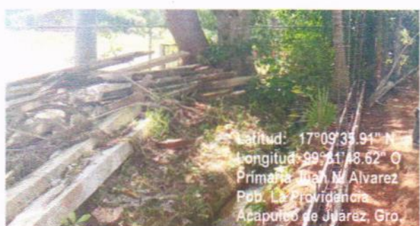
ACERO No. 4 (1/2") EN CIMENTACION INCLUYE HABILITADO, ARMADO, DESPERDICIOS, GANCHOS, TRASLAPES, SILLETAS, ALAMBRE RECOCIDO N° 18, FLETES, ACARREOS, PRUEBAS, HERRAMIENTA Y MANO DE OBRA.
