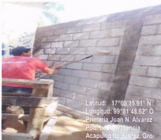
SELLADO EN MURO
